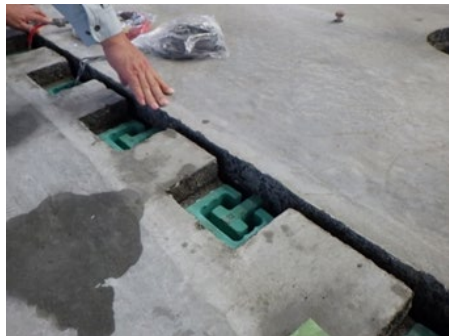
写真-1 継手挿入状況
