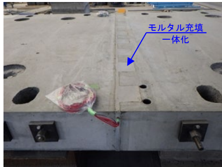
写真-2 一体化状況
