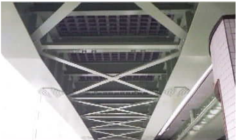
写真-1 信濃橋入路(ワッフル型UFC床版)
