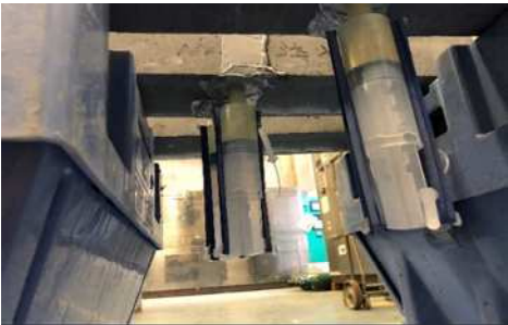
写真-3 自動式低圧注入工法による注入状況
