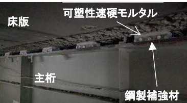
写真-4 ⑤仮補強材の設置 鋼製補強材と速硬化モルタルで構成する
