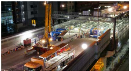
写真-6 ⑧床版の撤去・搬出状況 専用機による床版の吊上げ・移送
