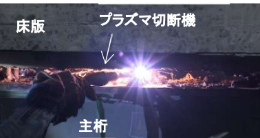
写真-5 ⑧スタッドの切断 10 秒/箇所ですべて切断、桁への入熱がない
