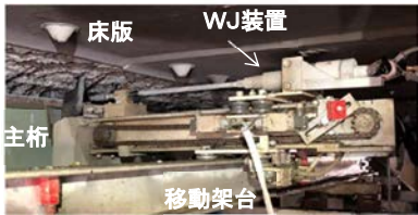
写真-2 ③WJ 研り装置 半自動の移動架台
