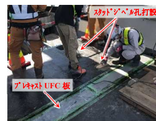
写真-3 プレキャスト UFC 板設置状況
