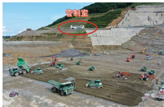
写真-1 自動化施工状況
