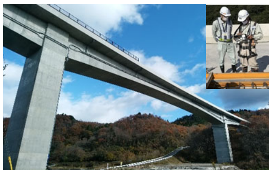
写真5 検査状況（東根川橋上部工工事）
