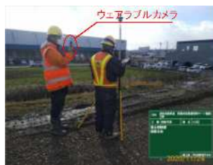
写真-1 現場の遠隔立会風景
