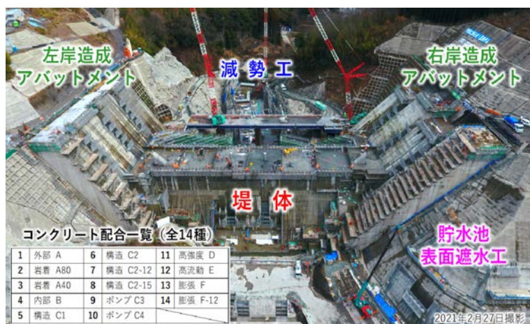
図-1 主要な施工箇所（玉来ダム）
