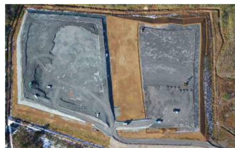
図-4 施工場所全景
