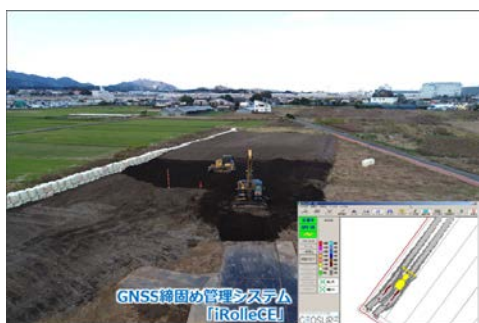
写真-2 盛土の施工状況
