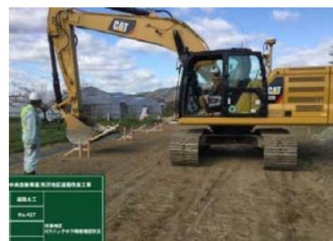
写真-3 バックホウ MG 位置確認状況
