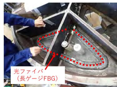
写真-2 規制板部の光ファイバ固定作業
