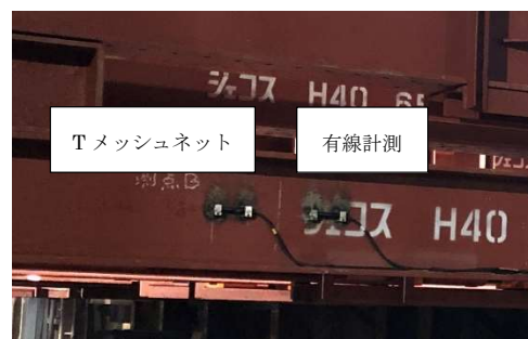
図-7 山留ひずみ計設置状況
