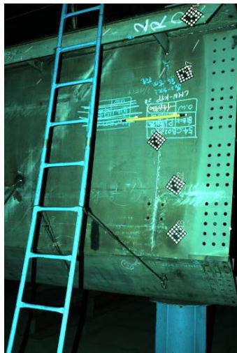
図-4 鋼桁腹板ボルト孔
