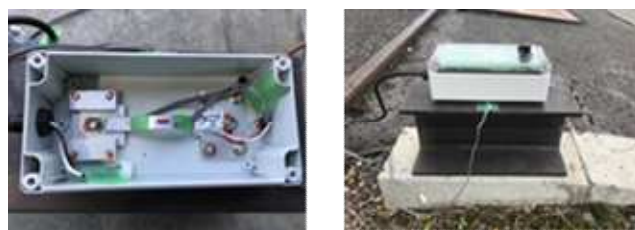
写真－3 センサー内部（左）と設置状況（右）
