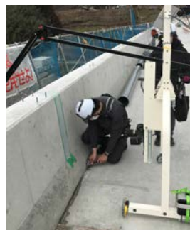
(a) 出来形計測状況
