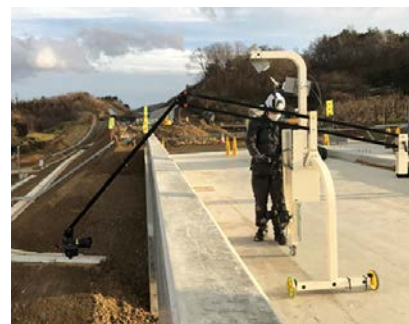
(b) ひび割れ撮影状況
