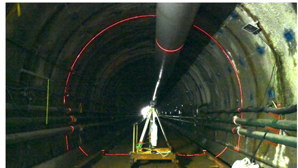
図4 トンネル断面の計測状況
