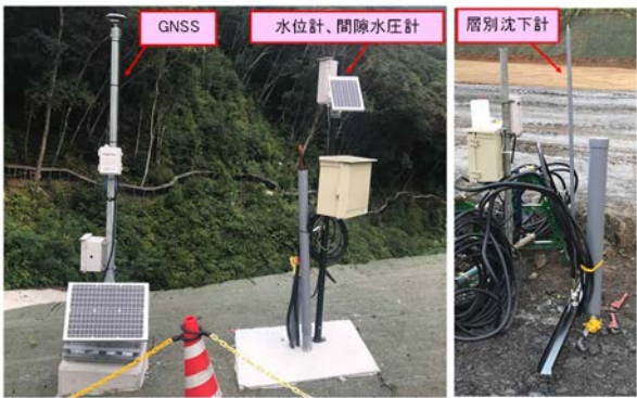
写真-1 機器設置状況
