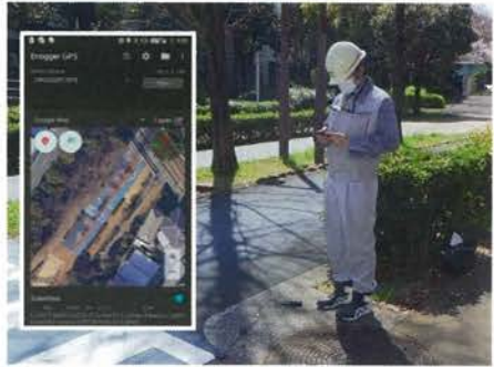
写真 3 現場での測定状況
