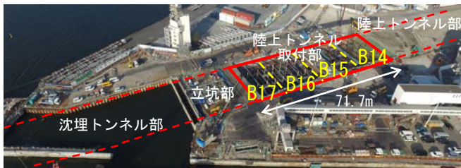
図 1 当工区全景写真
