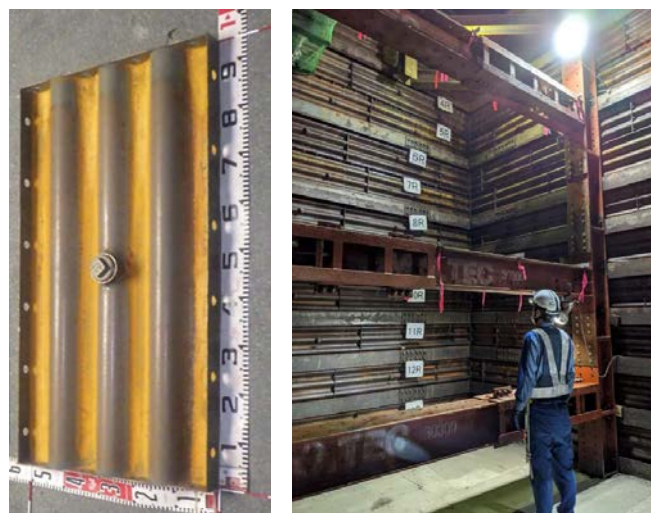
図-1 ライナープレート (h:500mm×b:950mm×t:2.7mm) および矩形立坑内
