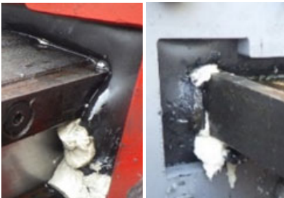
図－8 補助ゴムめくれ状況
