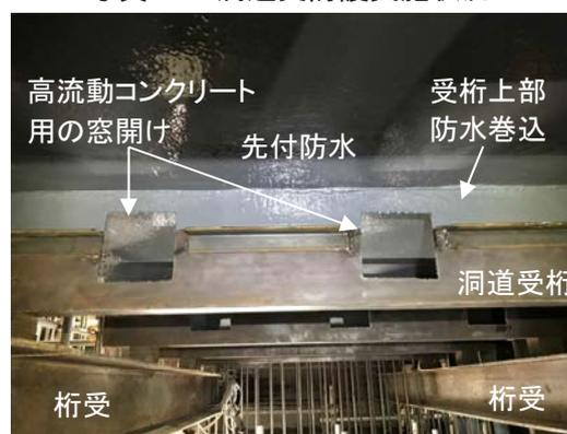
写真-2 通信洞道下部先付防水
