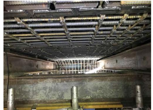
写真-3 洞道下部スラブ鉄筋組立
