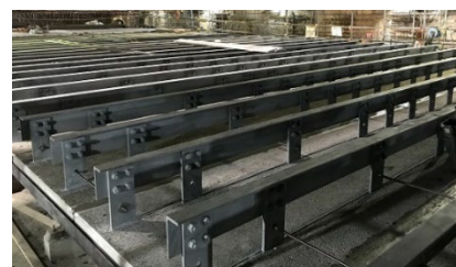
写真-2 埋設型枠設置完了
