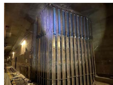
写真-1 止水壁④
