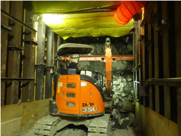
写真-1 導坑掘削状況写真
