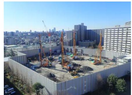
写真-1 静的締固め砂杭工法施工状況
