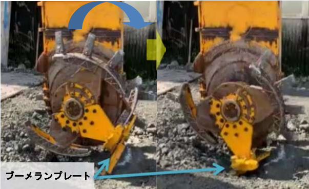
写真 3.1 コラム改良体掘削状況
