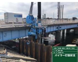
図5 鋼矢板打設状況
