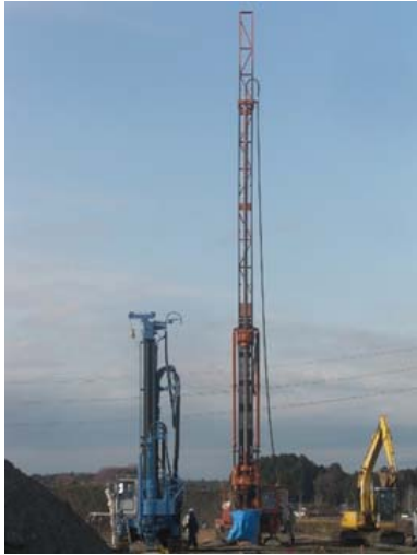
写真 1 施工機全景 (左: 汎用機 右: 従来機)
