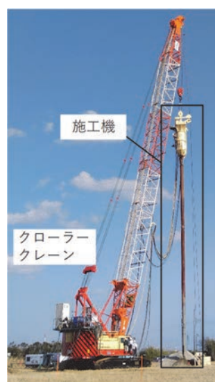
写真 1 施工状況写真
