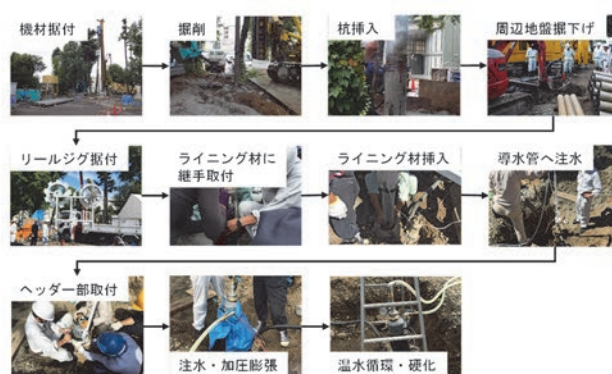
図-2 施工フロー
