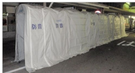
図1 アコーディオン防音壁 (防音シートタイプ，4 ユニット連結使用時)
