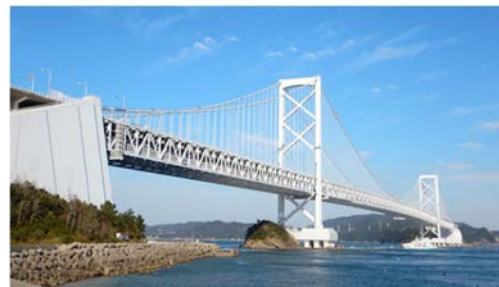
写真-1 大鳴門橋
