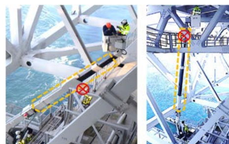
写真-4 安全装置の性能確認
