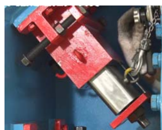
写真9 旧ビット引込み
