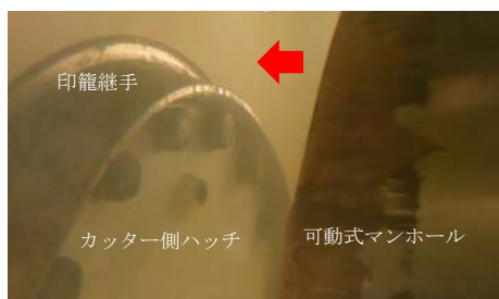
写真3 マンホール接続状況(水中)
