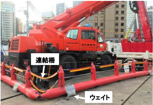
写真-4 立入禁止措置(昼間)
