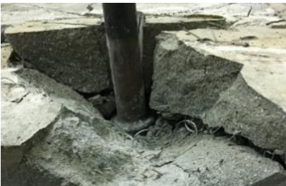
写真－2 RSF-PPF の破壊状況
