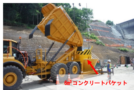
写真-3 積替え状況
