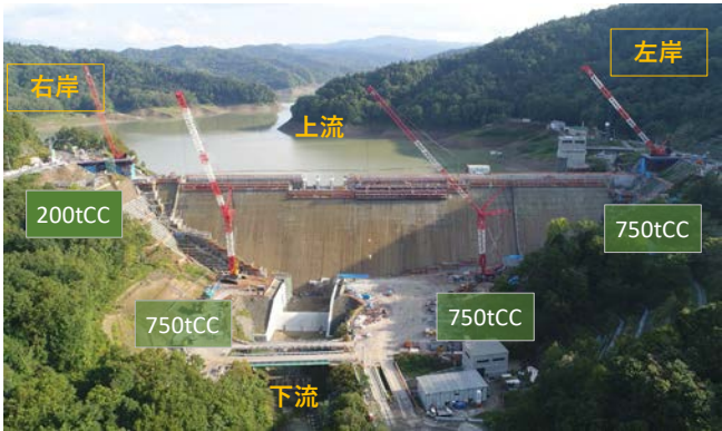
写真－1 打設用クローラクレーン配置図
