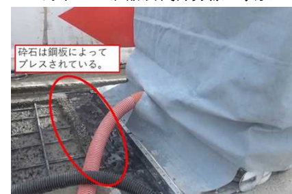
写真-6 はつり完了部の状況
