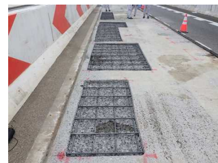
写真-4 はつり完了状況
