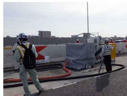
写真-3 試験施工状況
