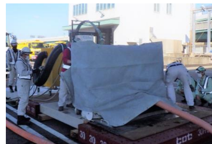
写真-4 はつり試験状況
