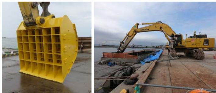
図-1 カルシア専用バケットと施工状況
