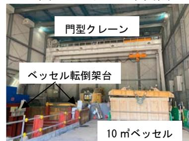
図-3 立坑掘削用仮設備
