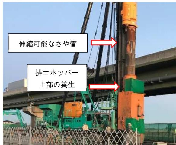
写真-1 飛散対策の実施状況(オーガスクリュー)
