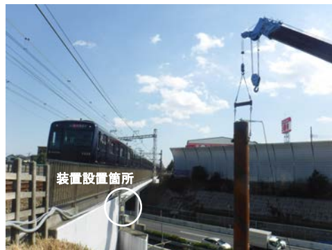
写真-2 装置設置状況
