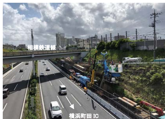
写真-1 鋼管杭打設状況
