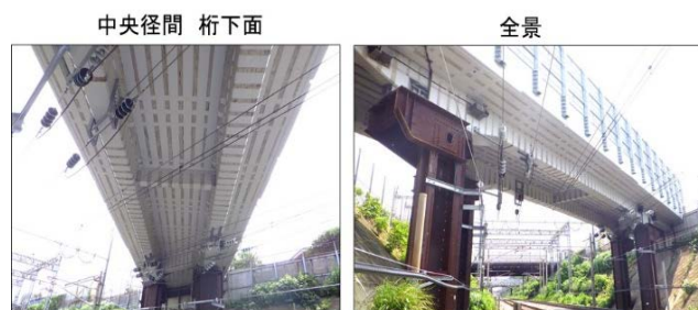
図-7 工事完了後
