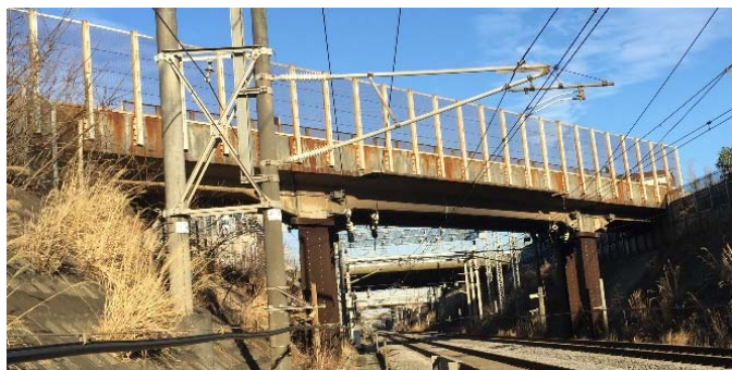
図-1 Bo 全景(着手前)
