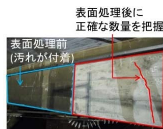
図-6 表面処理状況
