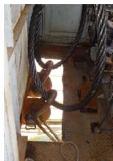
写真-2 吊ピース設置状況
