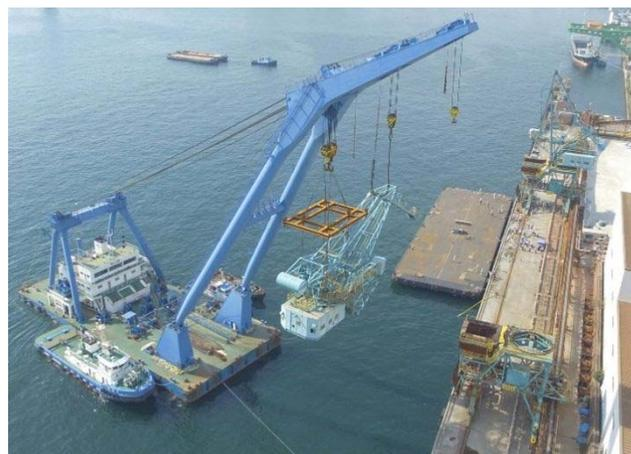
写真-4 アンローダークレーン撤去状況
