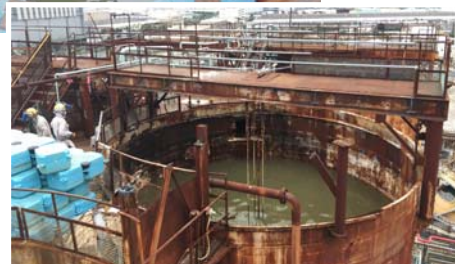
写真-3 作業状況
