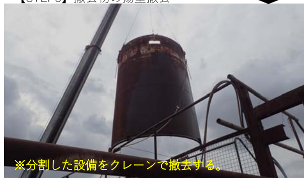
【STEP4】設備解体完了～フロート撤去
