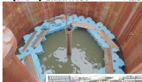
【STEP4】設備解体完了～フロート撤去
