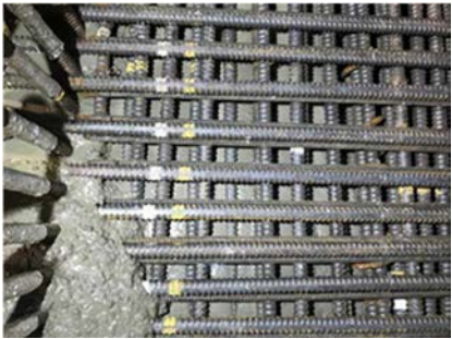
写真-3 高密度配筋部打設状況
