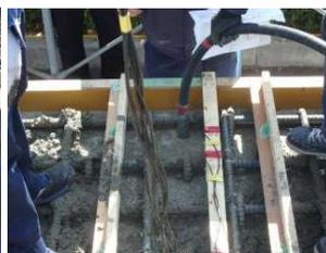
写真-3 バイブレータ起振状況
