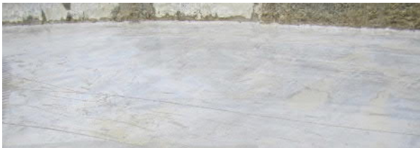
図-5 アクアソイル施工完了時の写真
